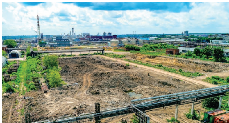
Готовится площадка под строительство. Фото с корпоративного сайта ОАО «Щекиноазот»
