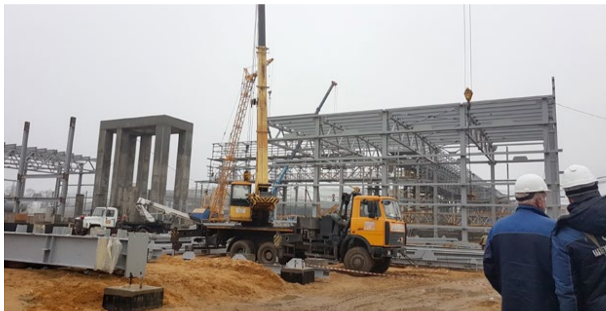
Установка «Метанол-500» строится
