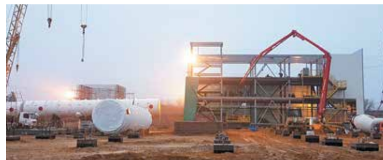
Реализуем крупные проекты. Строительство производства метанола на ОАО «Щекиноазот»
