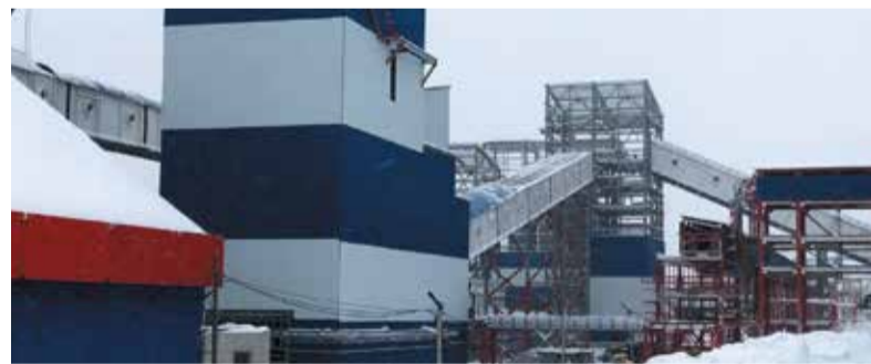
Реализуем крупные проекты. Строительство комплекса АКМ на ПАО «Метафракс»
