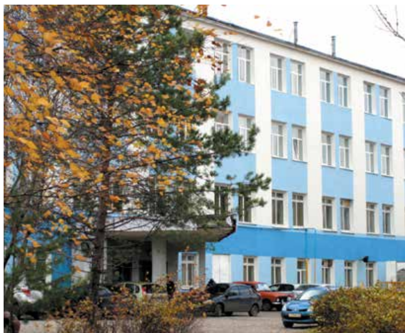
Здание научной части НИИК
