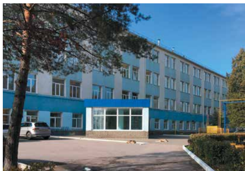
Здание научной части НИИК
