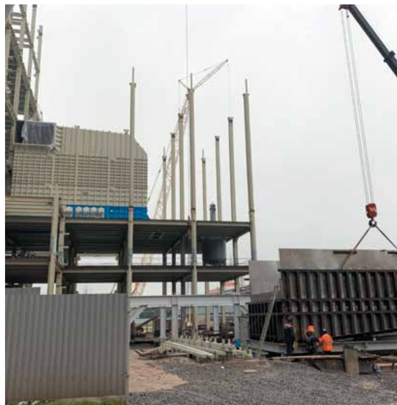
Установка грануляции строится
