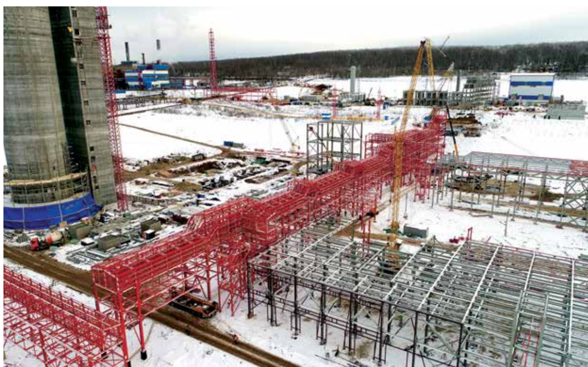
Строительство идет в любых погодных условиях. Фото: В. Балаухин
