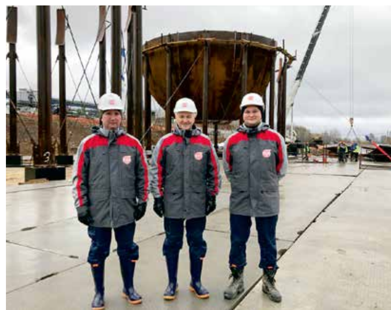
О.Н. Костин, И.В. Есин и Ю.А. Бычков на площадке строительства
