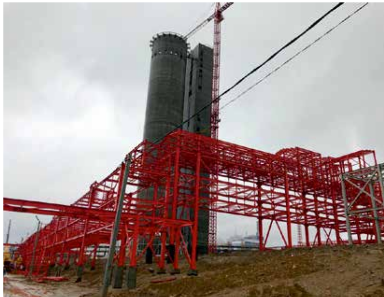
Эстакады PR-100 и PR-401 с видом на башню прилирования
