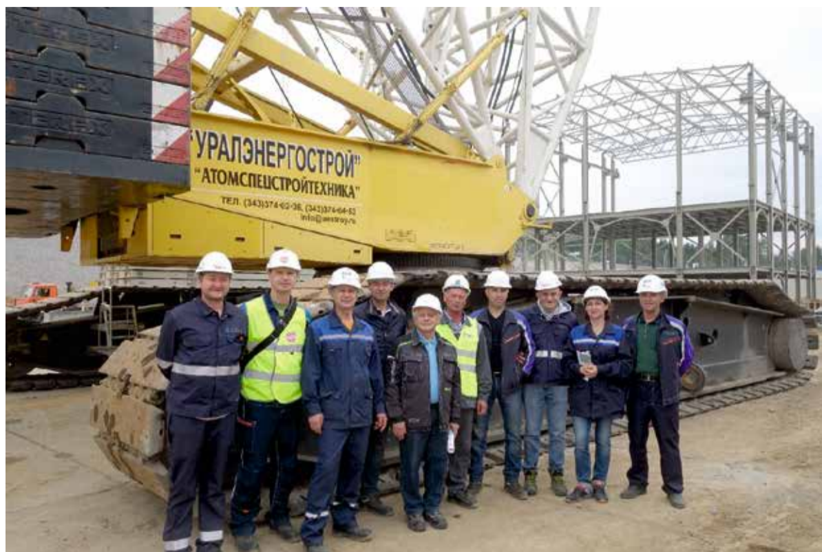
Обход площадки строительства. В центре – генеральный директор ПАО «Метафракс» В.А. Даут, второй слева – А.В. Винокуров
