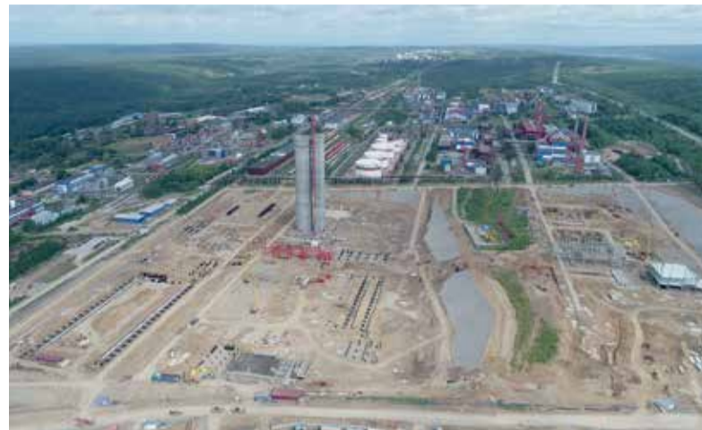
Панорама строительства комплекса АКМ. Август 2018 года
