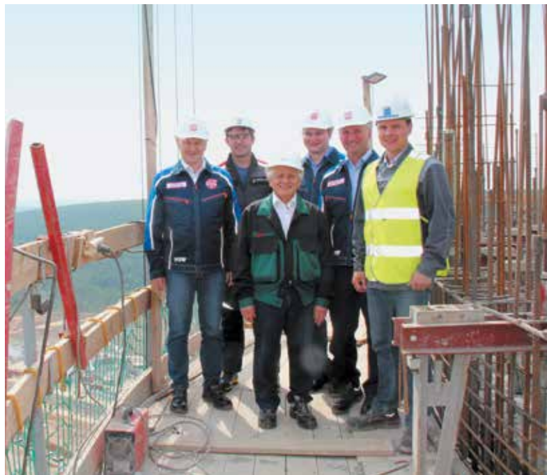
На строящейся башне прилливания
