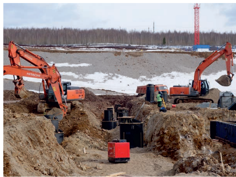
Прокладка сетей НВК на строительстве комплекса в Губахе
