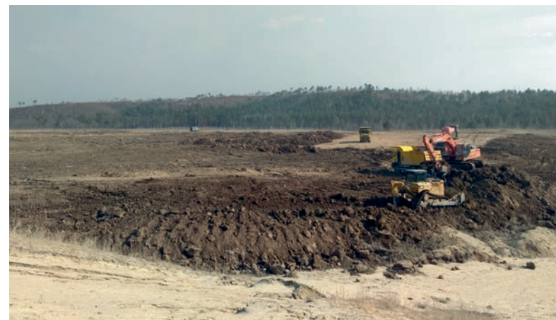
На строительной площадке
