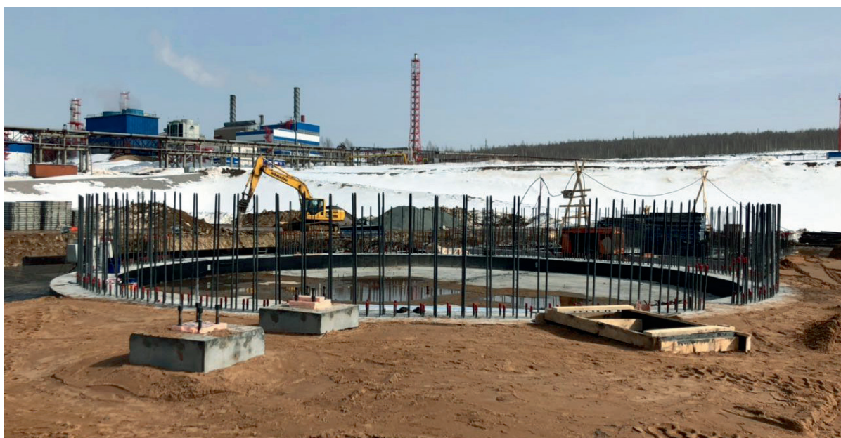
Фундамент башни завершен
