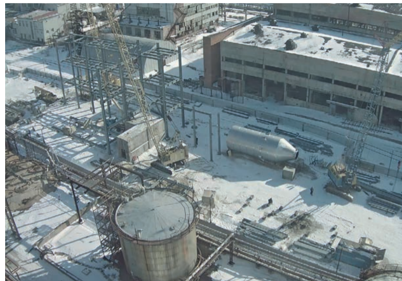
Производство карбамата МН строится
