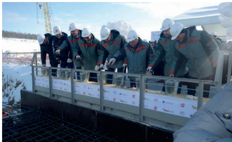
Заливка первого кубометра бетона
