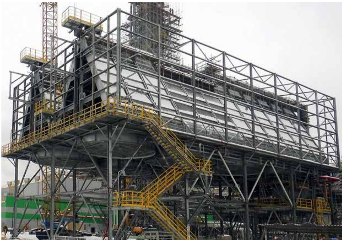
Строительство производства аммиака в Череповце
