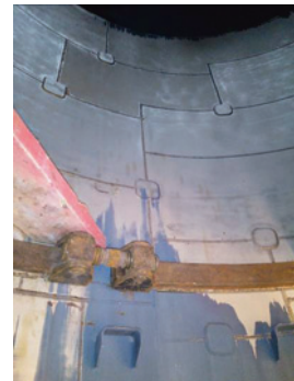
Рис. 1. Ремонтные накладки и вставки футеровки реактора карбамида
