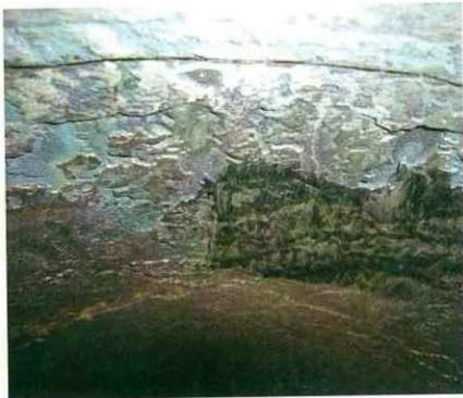
Рис. 1. Поверхность футеровки с язвами
