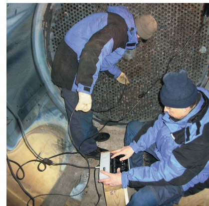
Коррозионное обследование оборудования с помощью вихретоковых замеров
