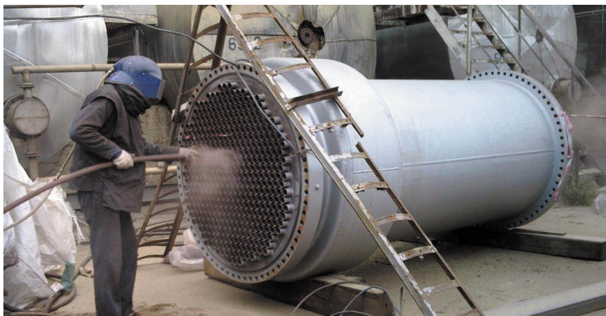
Чистка теплообменного оборудования
