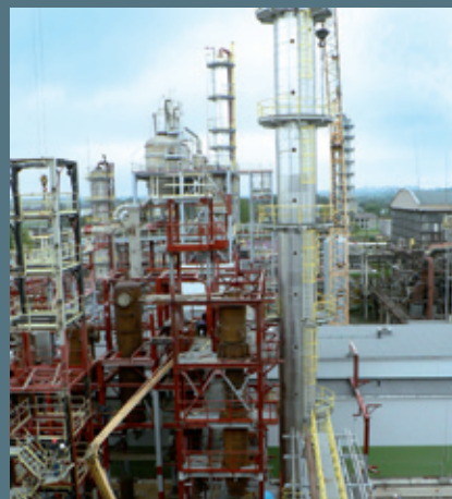
Строительство производства карбамида на АО «Ахема» мощностью 1000 т/сут. на базе перемещаемого оборудования (Литва, 2006-2007 г.)
