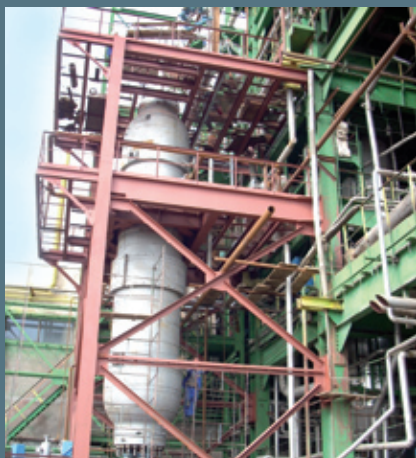
ОАО «Одесский припортовый завод» — реконструкция производства карбамида с увеличением мощности с 1000 до 1300 т/сут. (2007-2008г.)
