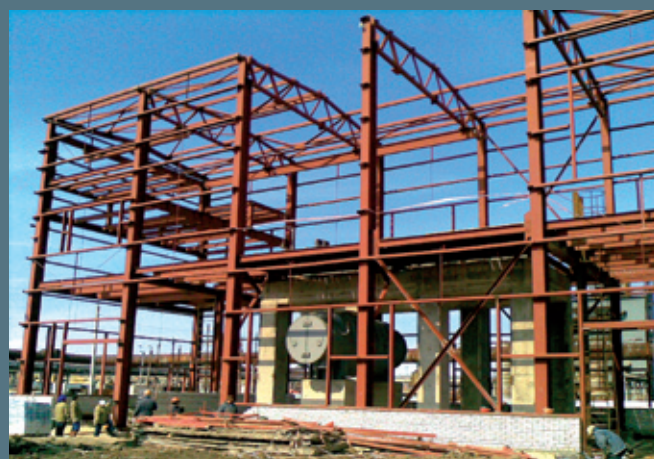
ОАО «НАК» Азот — начальная стадия строительства производства карбамида мощностью 1150 т/сут. на базе перемещаемой установки из Сербии (2007-2008 г.)
