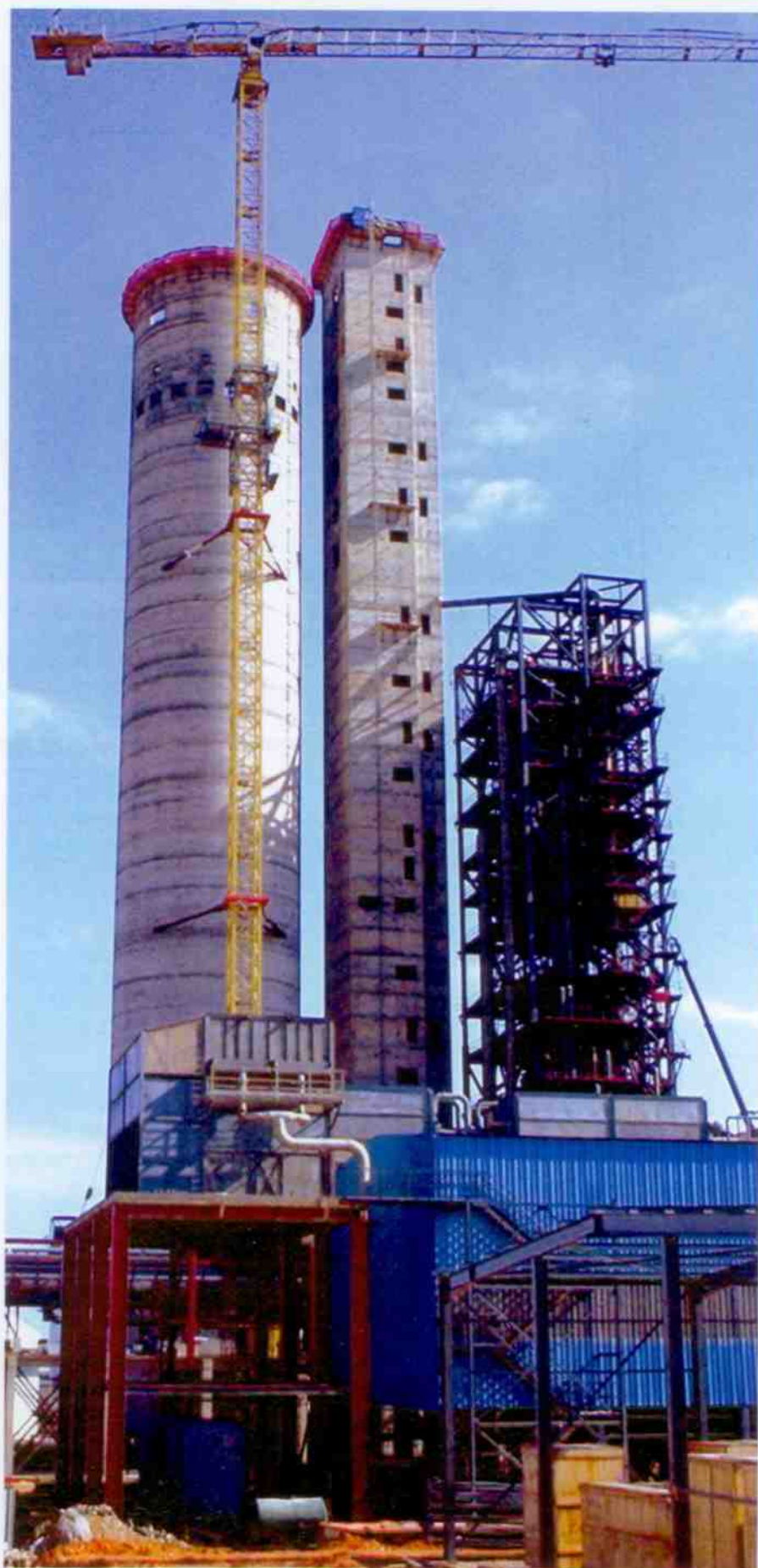
Грануляционная башня в Алжире, построенная по проекту НИИК
