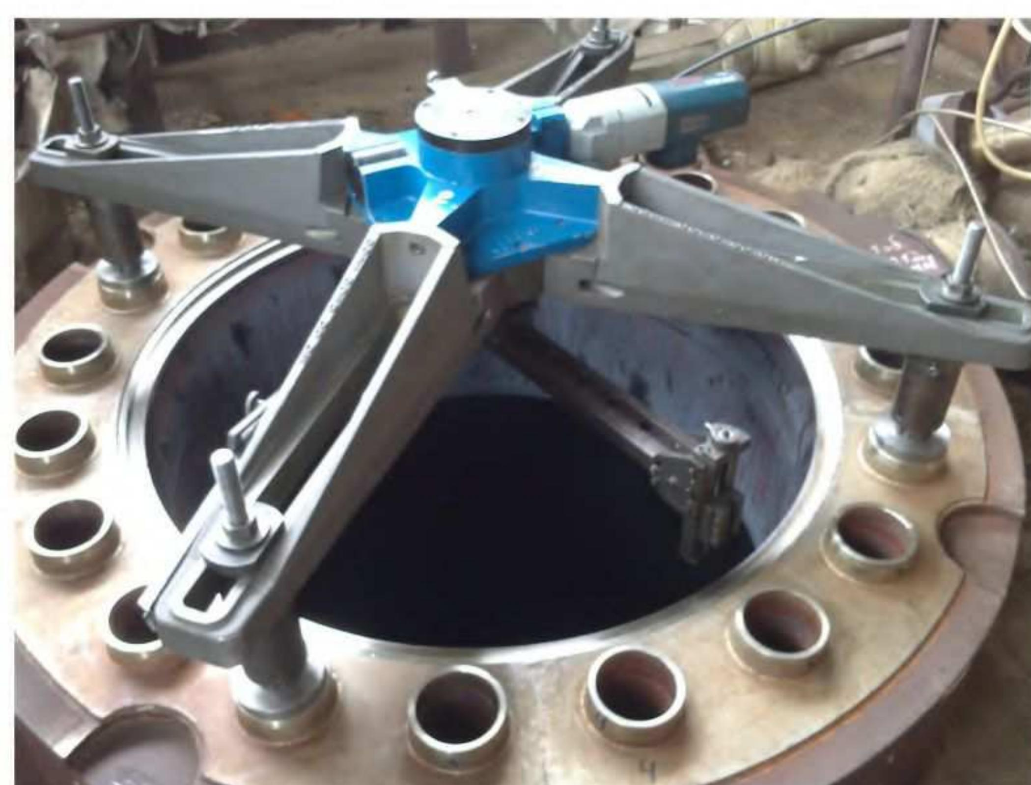
**Проточка уплотнительной поверхности реактора на ОАО «ГродноАзот»**
