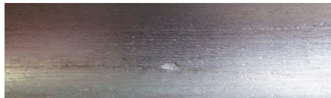
Рис. 8. Крупная язва и многочисленные мелкие язвы на внутренней поверхности трубы с повышенным шумом
