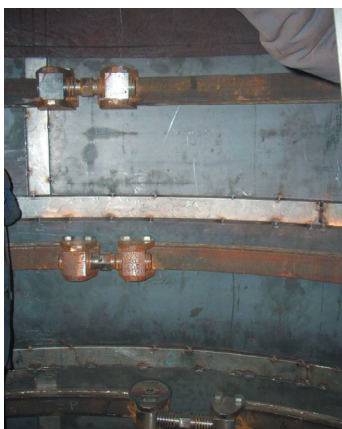
Рис. 8. Монтаж подложки и подкладных полос
