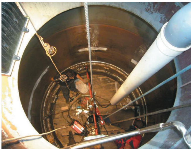
Рис. 11. Монтаж новой футеровки
