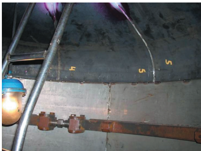
Рис. 4. Монтаж новой футеровки
