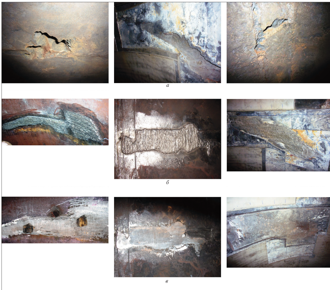
Рис. 6. Характерные отремонтированные дефекты: а – коррозионно-эрозионные поражения корпуса до заварки; б – после заварки, до зачистки дефекта; в – после зачистки заваренного дефекта
