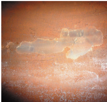
Рис. 1. Отремонтированный дефект корпуса реактора карбамида после 30 лет эксплуатации
