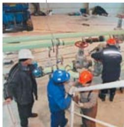
На водооборотном цикле продолжается обкатка насосов P501x, промывка трубопроводов, ведется продувка технологических линий, завершаются работы на трубопроводах цеховой эстакады.
