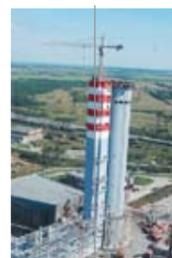
На производстве карбамида проведена уникальная операция – подъем газоочистной установки на башню приллирования. При помощи трех лебедок с использованием полиспастов конструкцию весом 500 тонн (!) с оборудованием подняли на высоту 100 метров.
